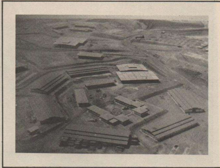
Aspecto de un "núcleo" de los 17 que debían construirse.
