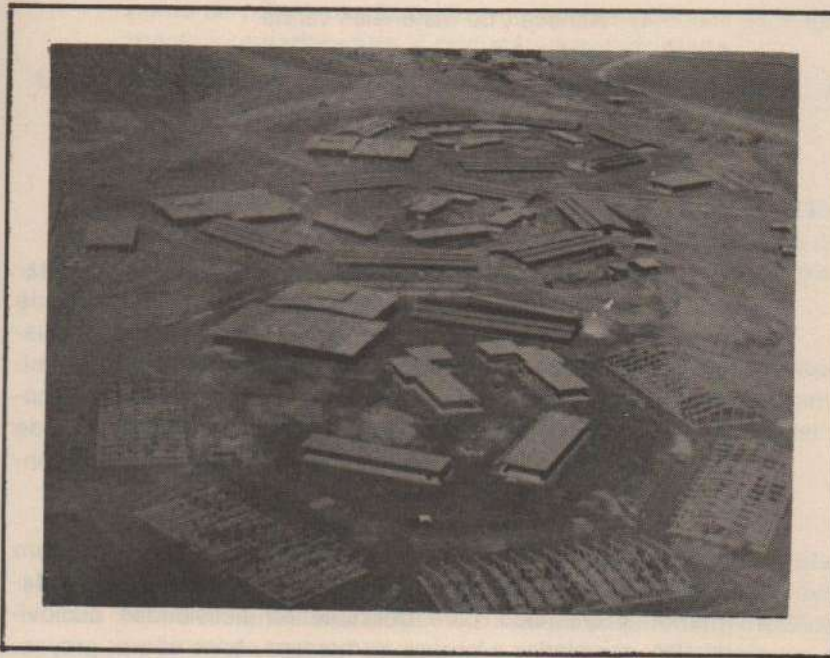
Tres (3) "núcleos", de los 6 que se dejaron prácticamente terminados.
