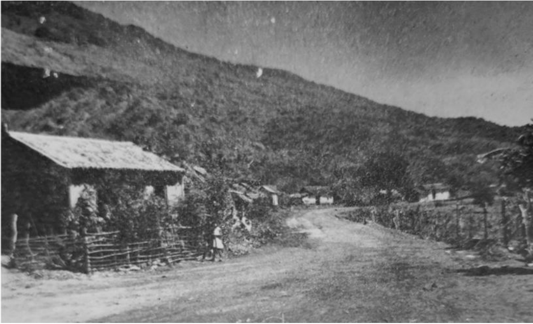
Tramo carretera Paraguachí - La Rinconada, en construcción.
