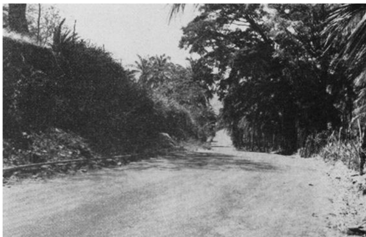
Asfaltado R. C. 2. San Juan Bautista - Fuentidueño.
