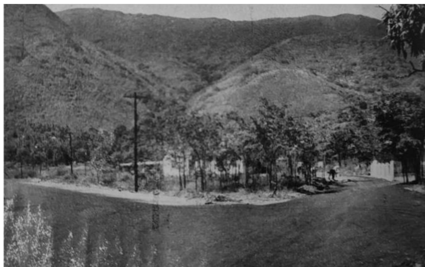
Asfaltado R. C. 2. Valle Espiritu Santo - Las Piedras.
