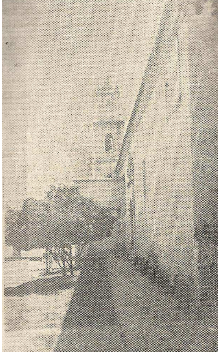
TORRE Y FACHADA LATERAL IZQUIERDA DEL TEMPLO MATRIZ
